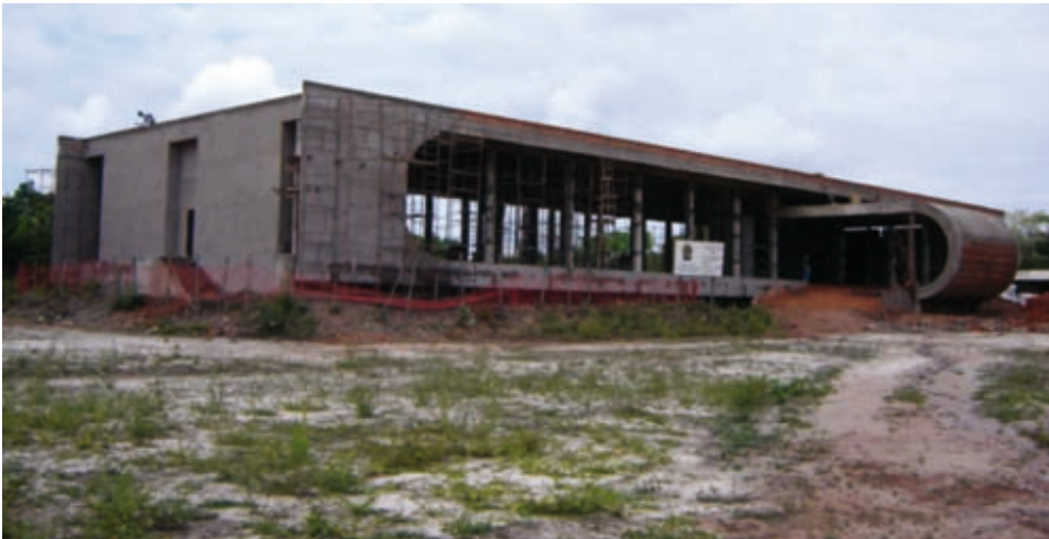
Obra da sede da Subseção Judiciária de Caxias/MA.
