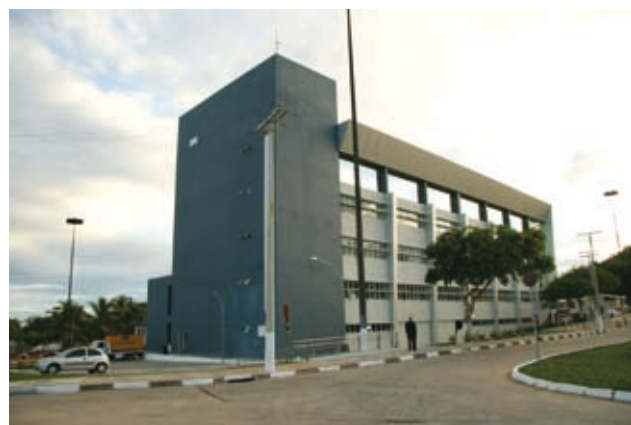
Prédio dos Juizados Especiais Federais de Salvador.
