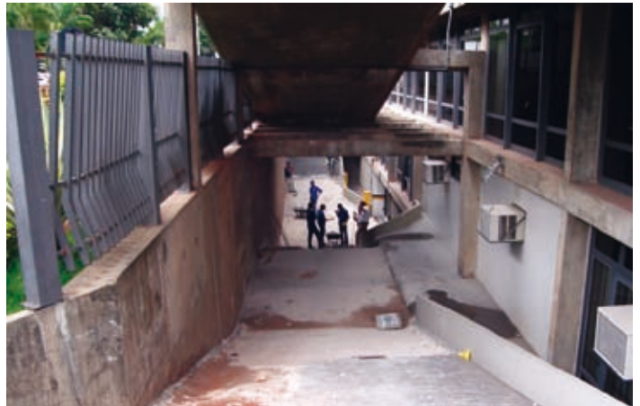
Impermeabilização do edifício Cabo Frio.
