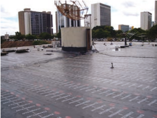
Impermeabilização do Edifício-Sede do TRF 1ª Região.
